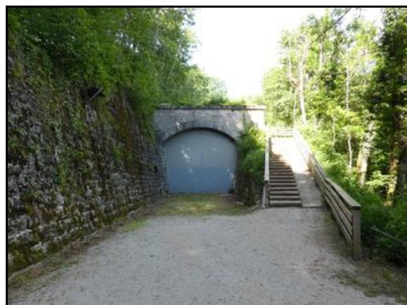
Un peu plus loin, pour sortir de la reculée de Revigny et déboucher sur le plateau, la voie ferrée franchissait une profonde tranchée qui a été elle aussi recouverte pour éviter les chutes de pierres
