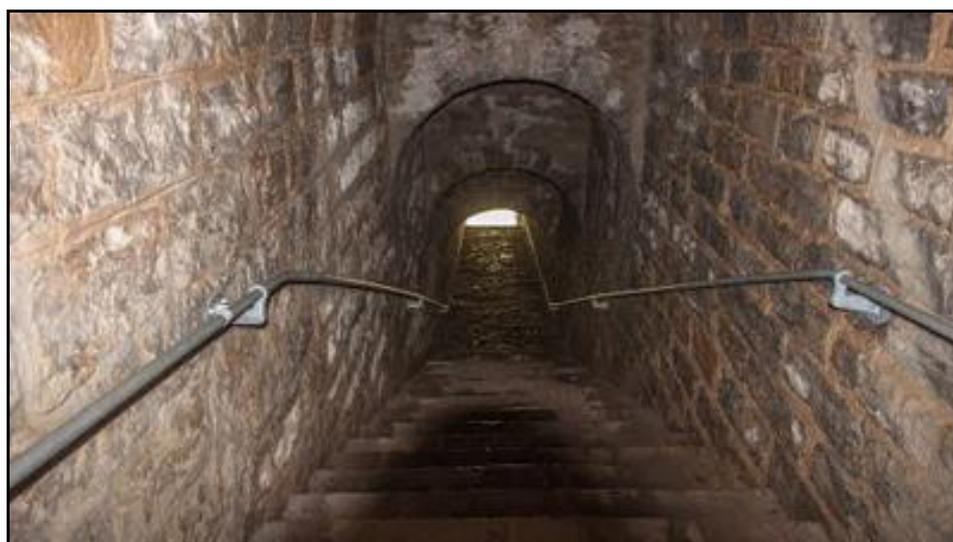
L'intérieur du souterrain avec sa voûte à ressauts
