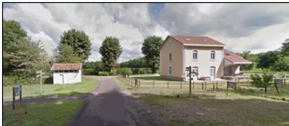
Vue côté cour et côté voie
