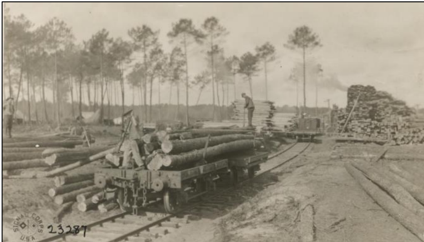
27 août 1918. Chargement et empilage des grumes sur les wagons de la voie normale.
