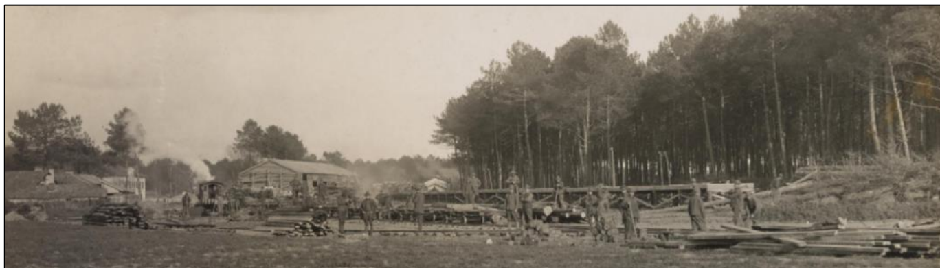
Avril 1918. Autre vue du quai de chargement en cours de construction.
