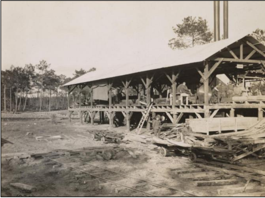
Avril 1918. La scierie située dans le prolongement du canal.
