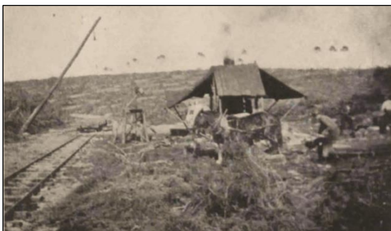
Débardeur à vapeur à proximité du Courant de Sainte-Eulalie.
