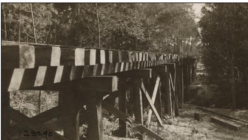
27 août 1918. Pont de 600 pieds de long (environ 180 m) construit en deux semaines par la 42 ème compagnie.
