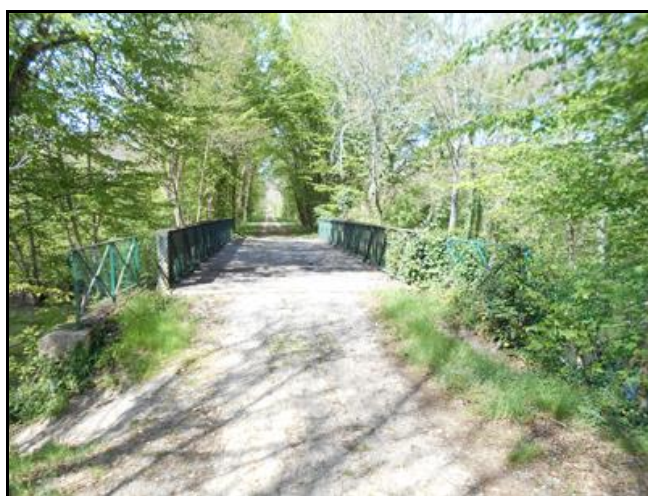
Au sud de la Massoterie, la voie ferrée franchissait les deux bras de la Sauldre sur deux ponts métalliques à poutres latérales ajourées
