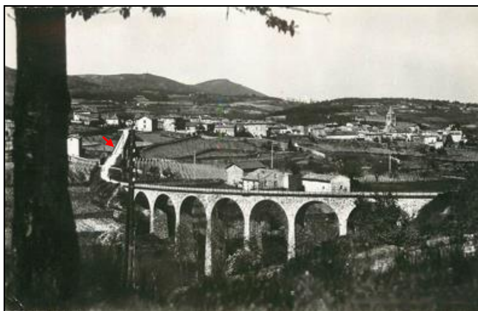
Vu à contresens, le viaduc de Charavine avec, à l'arrière-plan, Pélussin et le viaduc (flèche rouge)
