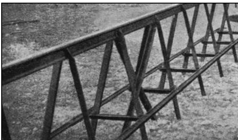
Le principe du monorail avec son rail de roulement supérieur et ses rails de guidage latéraux
