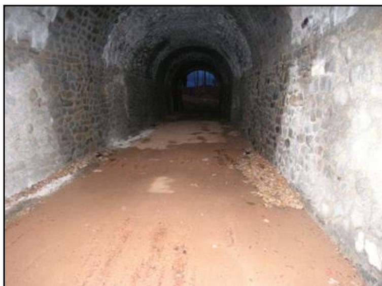
A Saint Symphorien de Lay, pour éviter la RN 7 très fréquentée, même à l'époque, la voie ferrée empruntait un court faux tunnel de 30 m construit sous la chaussée
