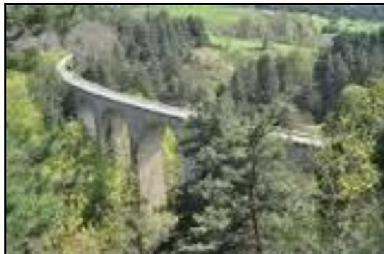
Presque aussitôt suivi du viaduc des Combes ou de Roure, en maçonnerie avec 7 arches plein cintre
