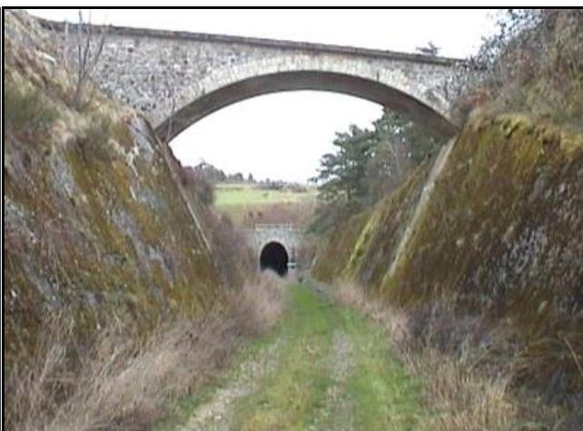
Puis, un peu plus loin, au fond d'une longue tranchée surmontée par un pont en maçonnerie à arche surbaissée, le tunnel de Roure Lantriac, de 190 m, qui fut un temps transformé en fromagerie, ce qui explique la présence d'une porte à sa sortie
