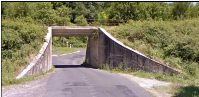
A la sortie de la gare, la ligne saute la route RD 633 par un pont en béton qui a été équipé de ses garde-fous
