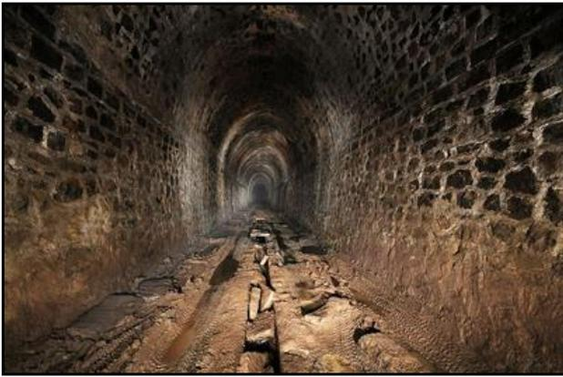
Le drain central dont les dalles de protection sont fracturées
