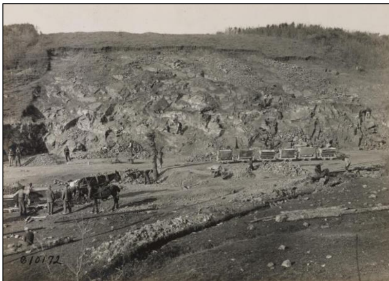
Préparation du terrain avant la construction du barrage.
