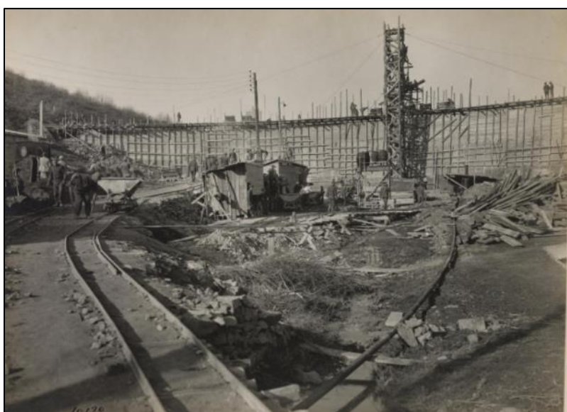
Deux vues du barrage en avril 1918.
