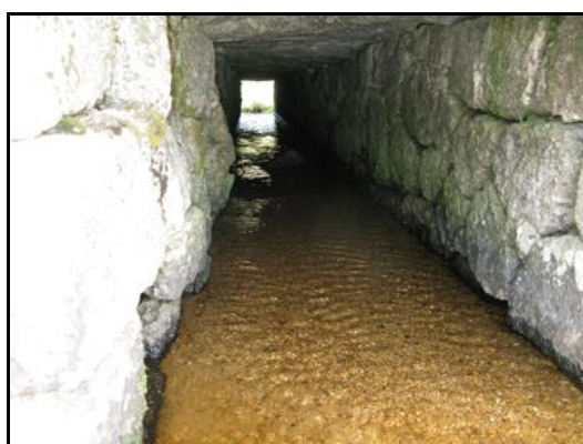
Ci-dessus et ci-dessous, le joli petit ponceau en pierres de taille de Fouon del Rougio
