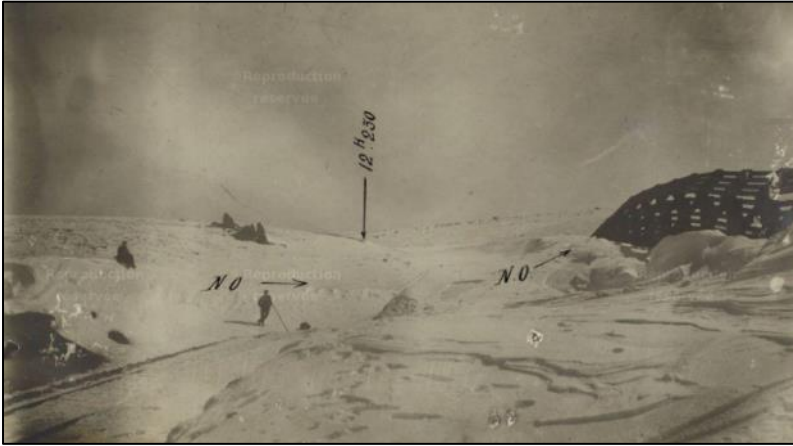
Au niveau du Pk 12+230, non loin du ravin de la Fouon del Rougio.
