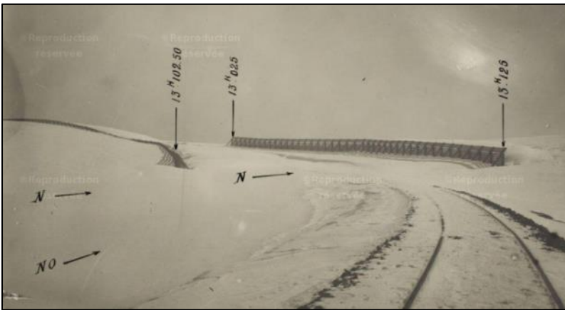
Entre les Pk 13+125 et 13+025.
