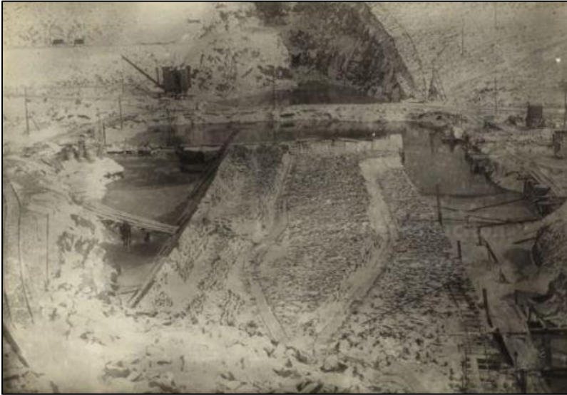
Les fondations, vraisemblablement durant l'hiver 1925-1926, après les premières chutes de neige.
