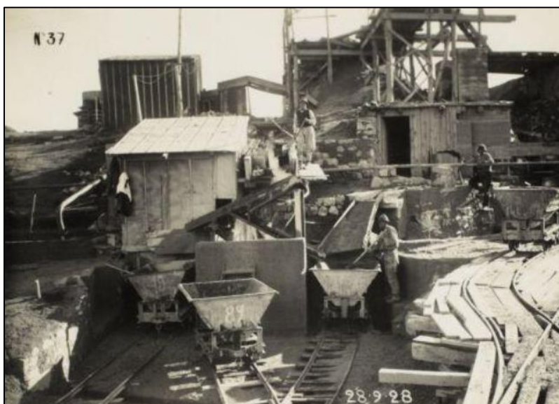
28 septembre 1928. Remplissage des wagonnets en dessous de l'estacade.
