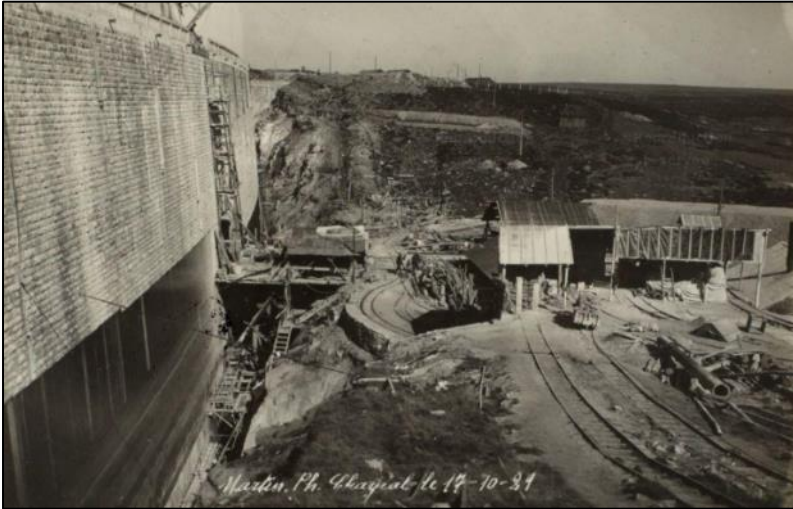
Même date, côté amont, photo prise en direction du Nord.
