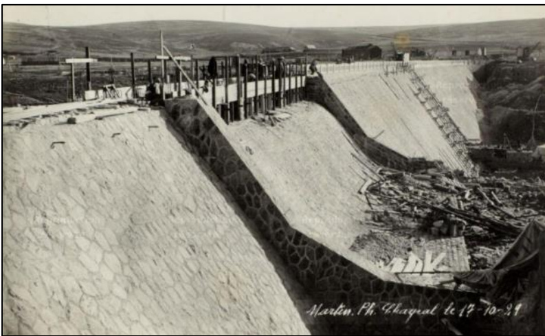
Même date, côté aval, avec l'évacuateur de crue. On aperçoit la remise des locomotives en arrière-plan.
