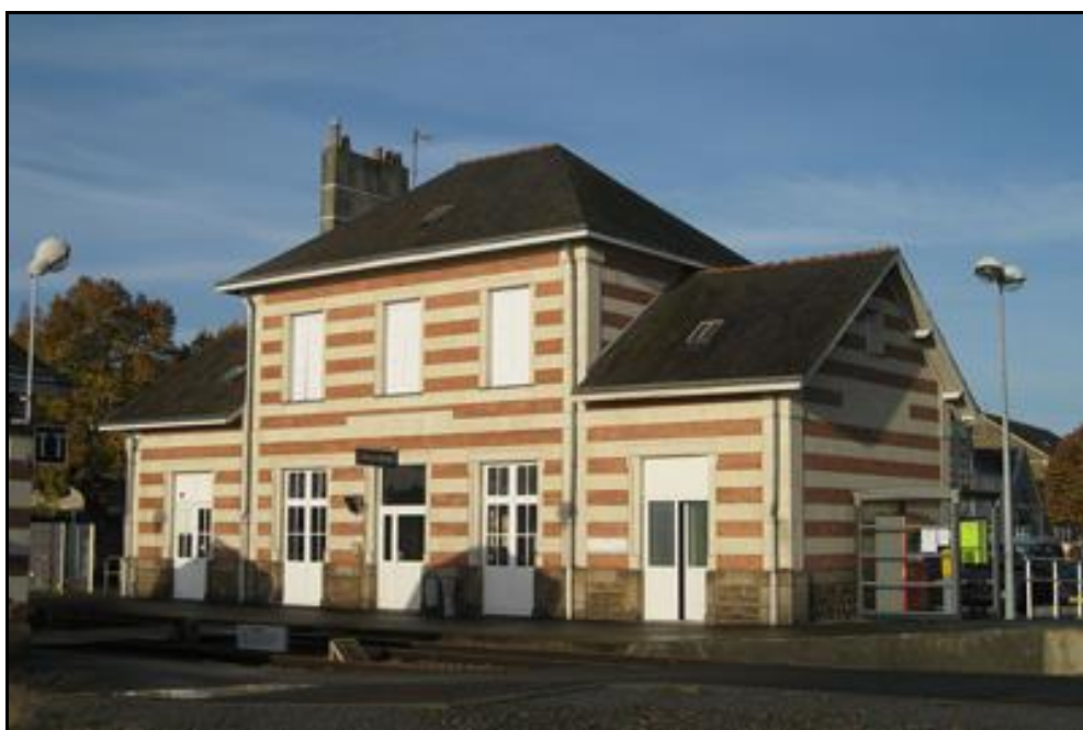
Aujourd'hui, la gare de Chalonnnes sur Loire, côté voies
