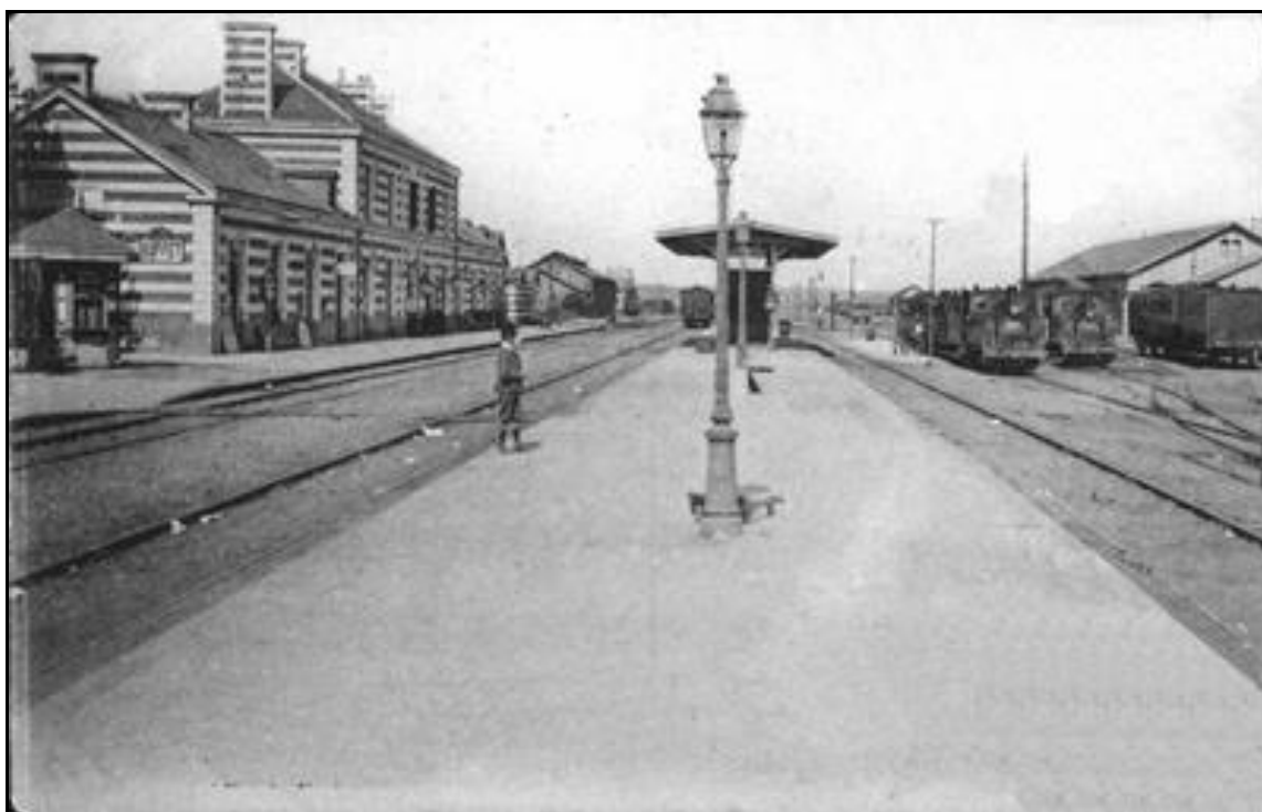
Cette photo ancienne montrent que les voies du Petit Anjou (ici sur la droite) se trouvaient à l'opposé du bâtiment voyageurs, à côté de la gare de fret
