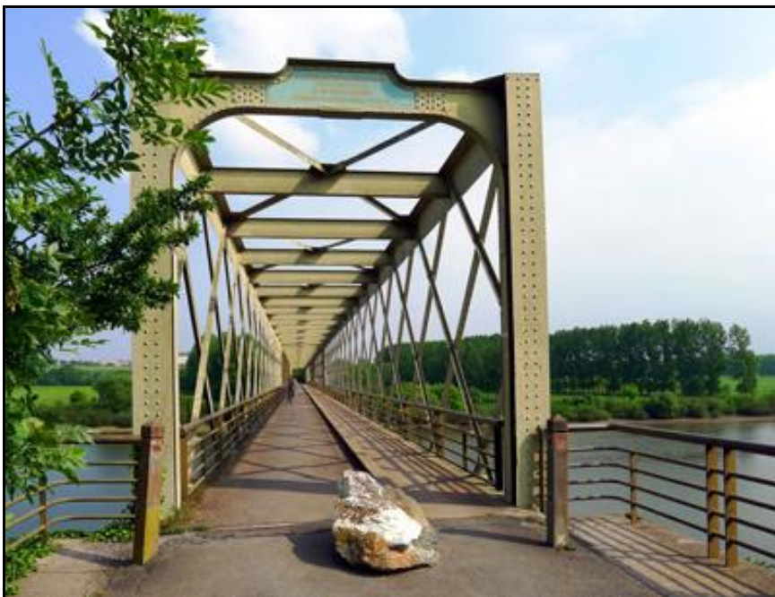
Le pont de Pruniers vu depuis la rive droite de la rivière, en regardant vers Angers
