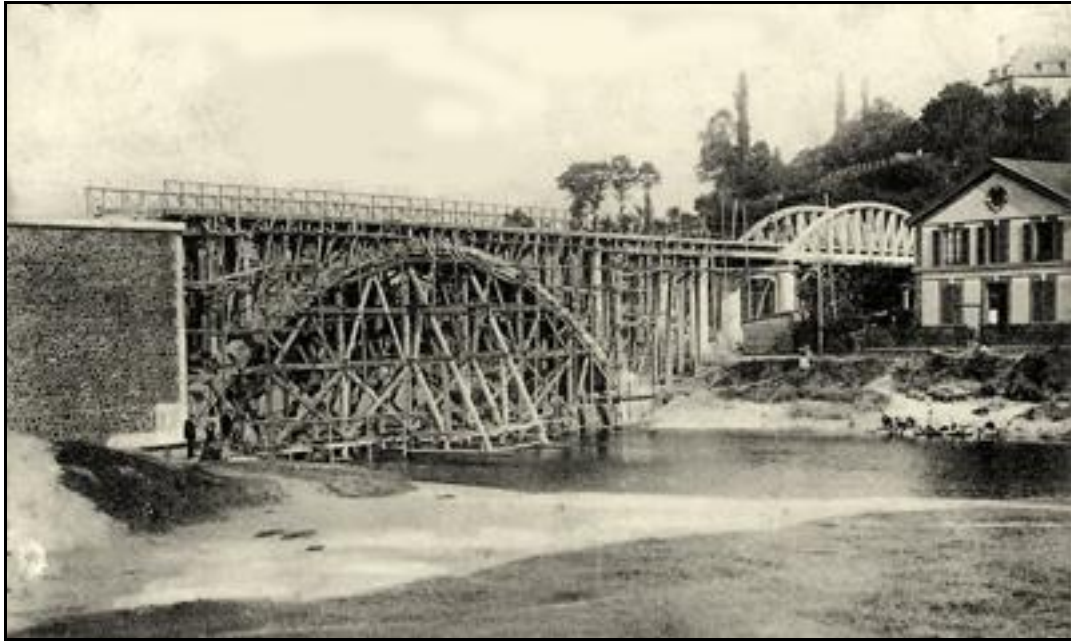
Le pont tout béton en construction
