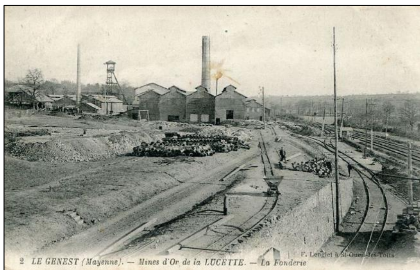
Le port sec et l'embranchement particulier. En arrière-plan la nouvelle usine et le puits Portier.
