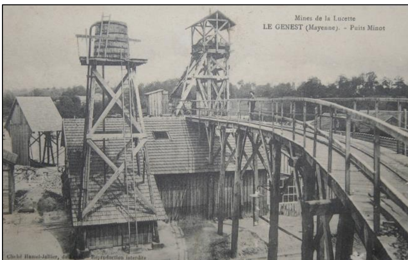
Le puits Minot avec sa passerelle desservant un terril, photographié sous un autre angle.
