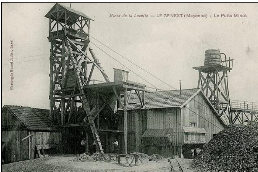
Le puits Minot et sa laverie alimentée par le petit château d'eau.
