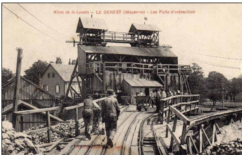
Les puits Georges et auxiliaire et la passerelle commune. La voie se dégageant sur la droite dessert un terril.
