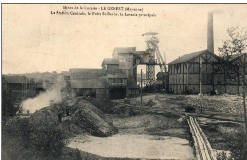
A l'arrière du puits Sainte-Barbe, on aperçoit des voies certainement destinées à évacuer les stériles. A droite, la station centrale.
