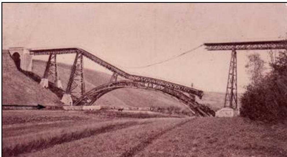
Ci-dessus et ci-après, le viaduc détruit
