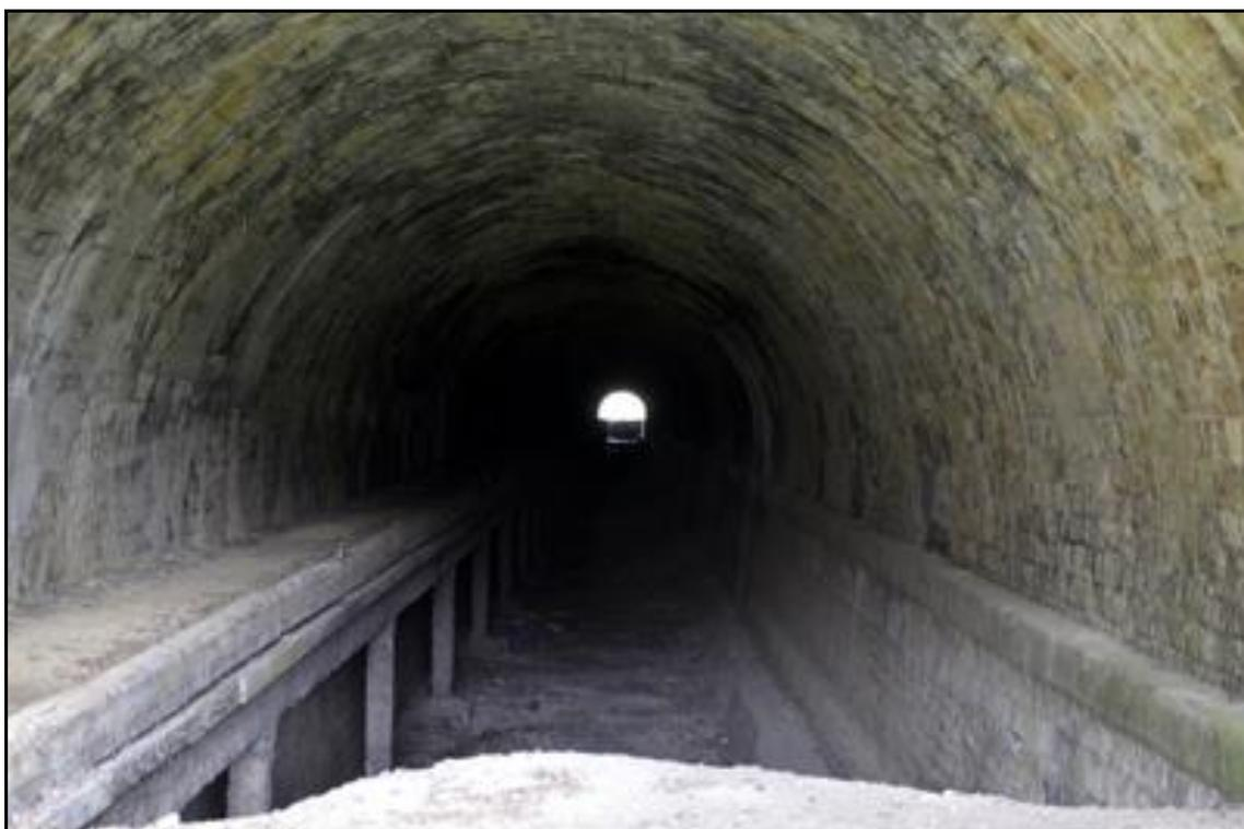
Vue ici dans le sens du tunnel, de l'entrée vers la sortie, la galerie maintenant asséchée avec sa banquette latérale qui recevait le chemin de fer de halage
