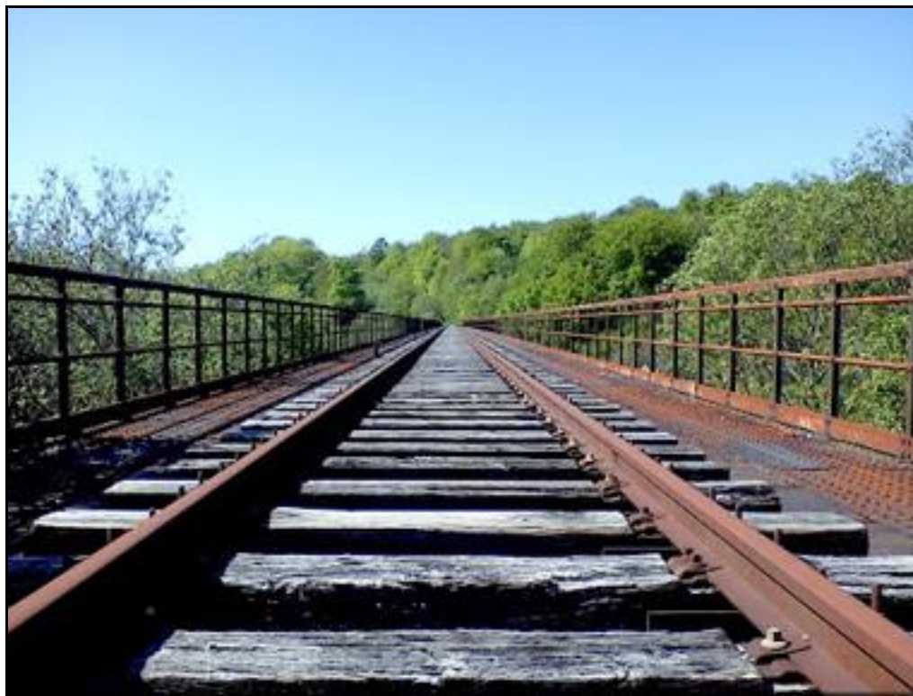
Le dessus du viaduc vu dans le sens de la ligne
