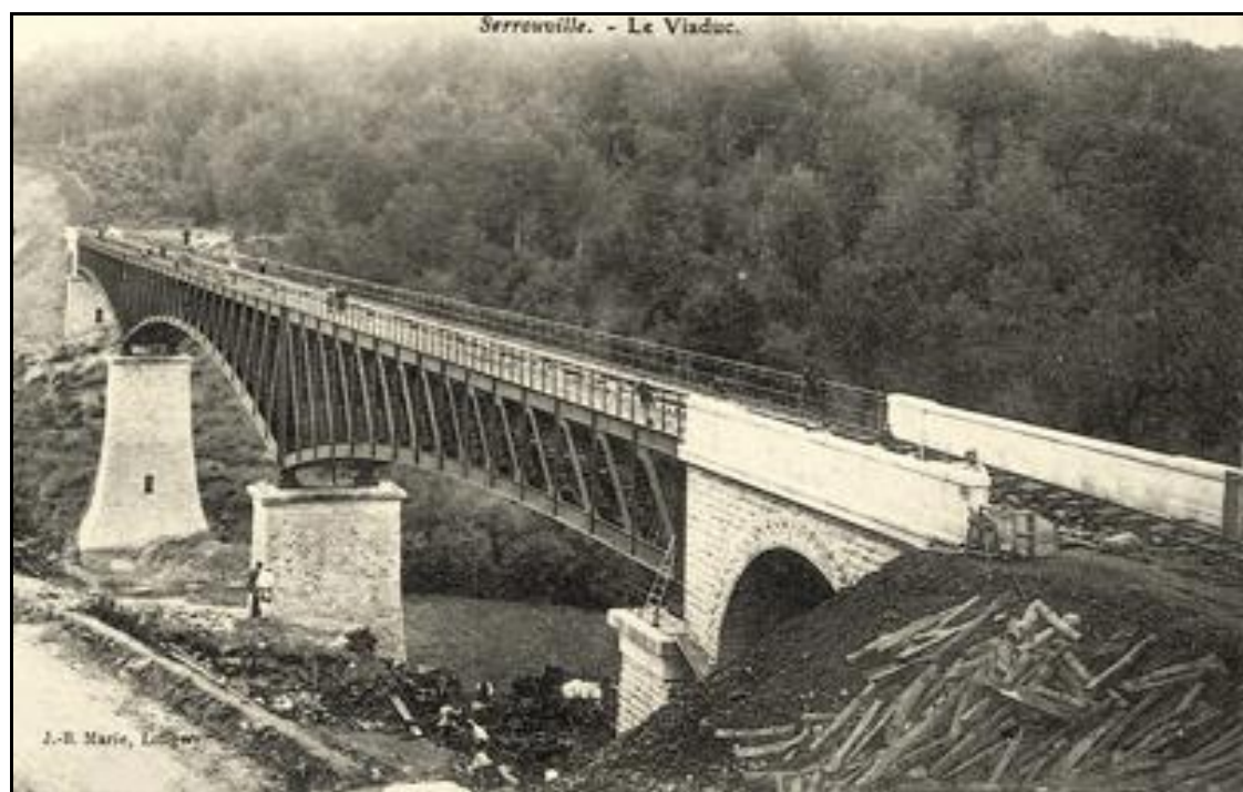
Les dernières finitions de l'ouvrage quasiment terminé On voit une petite voie de chantier mais la voie ferrée définitive n'est pas encore posée
