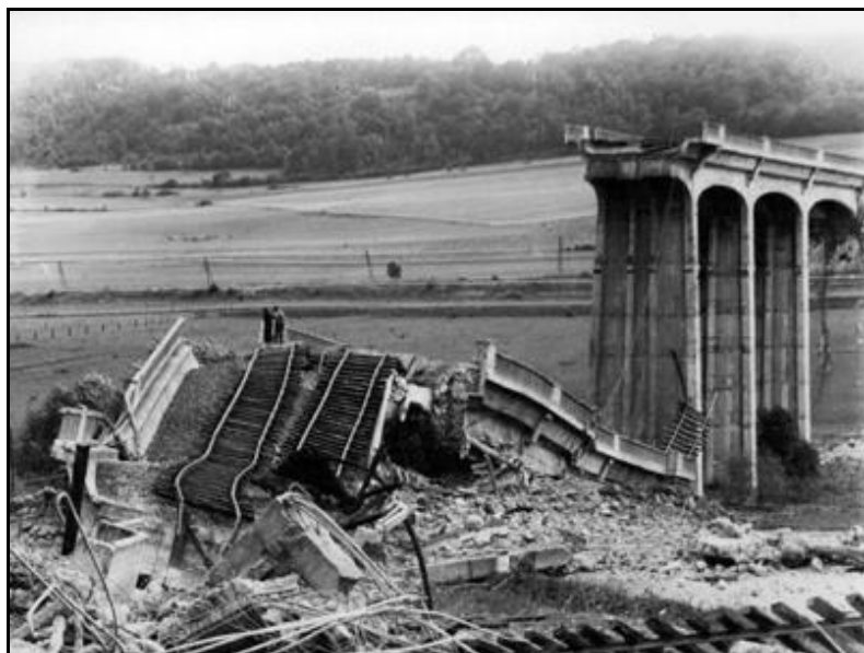
Ci-contre et ci-après, le tablier détruit, tombé au sol
