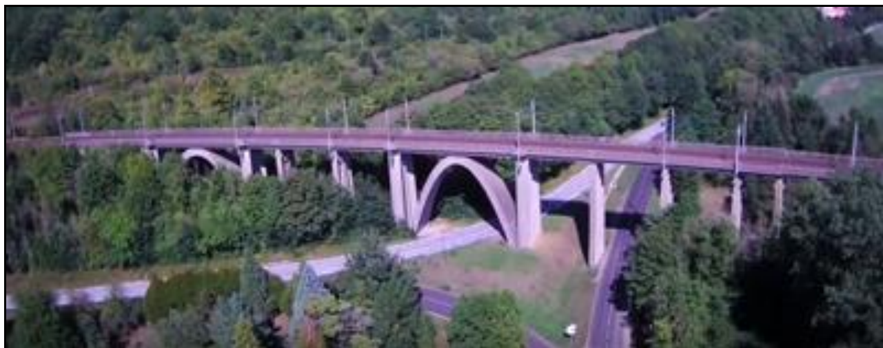
Ci-contre, la fin du viaduc vue par son côté gauche
