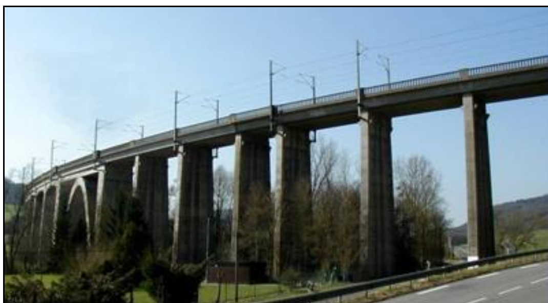
Ci-dessus et ci-après, diverses vues de l'ouvrage
