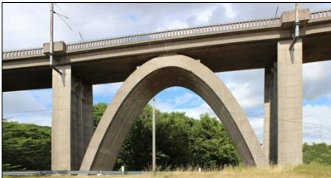
Ci-dessus et ci-dessous, détail d'un arc reconstruit à la place d'une des anciennes grandes arches détruites
