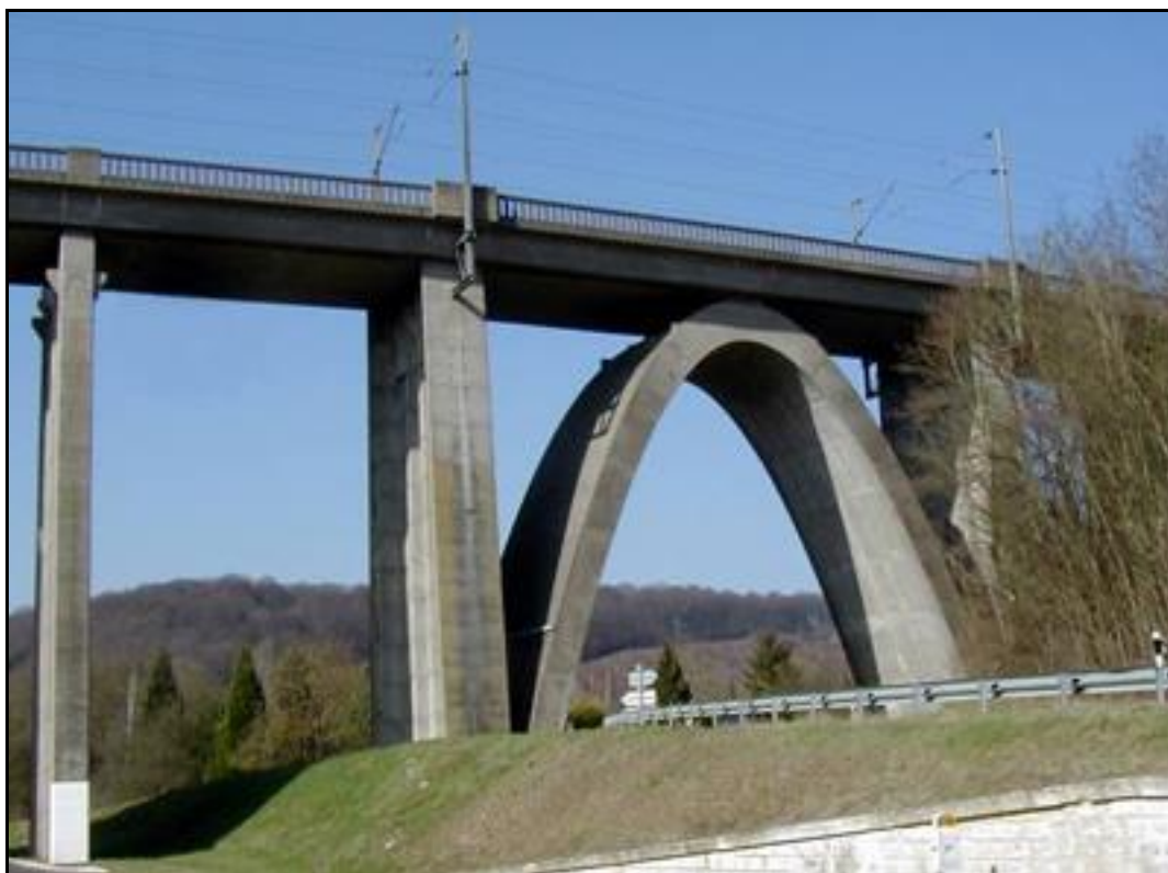
Ci-dessus et ci-dessous, détail d'un arc reconstruit à la place d'une des anciennes grandes arches détruites
