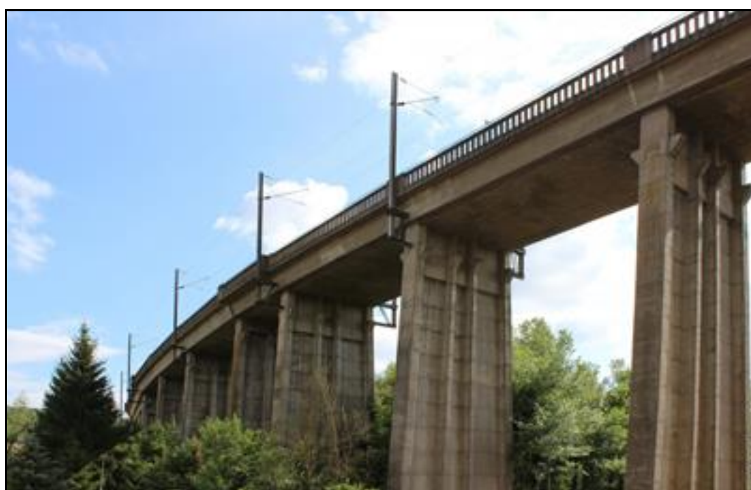
Détail des piles avec leurs nervures verticales de renfort
