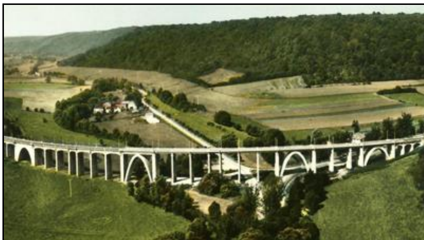
Vue générale de l'ouvrage reconstruit, photographié par son côté droit
