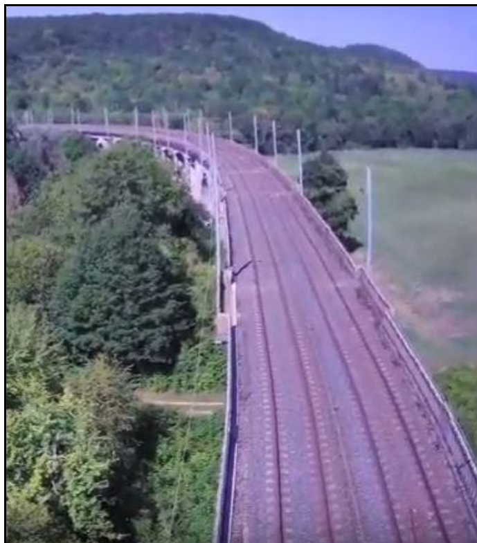
Le dessus de l'ouvrage
