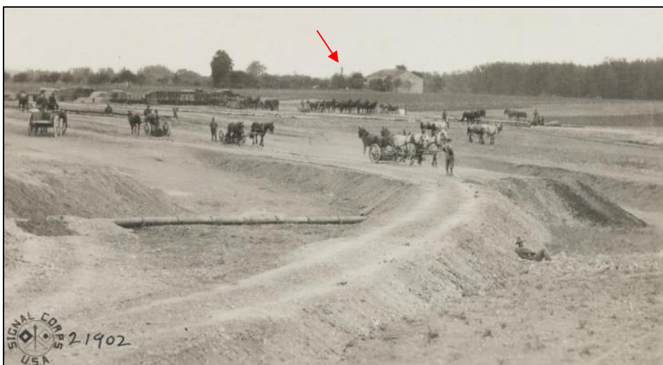
Retour en août 1918 avec le terrassement dans le même secteur. La vue est prise en direction du Sud, à droite de la photo précédente. On aperçoit au fond, pointé par la flèche, une cheminée de l'usine du Granit (forges jusqu'en 1904 puis usine de matériaux à partir de 1906 qui lui donna son nom).
