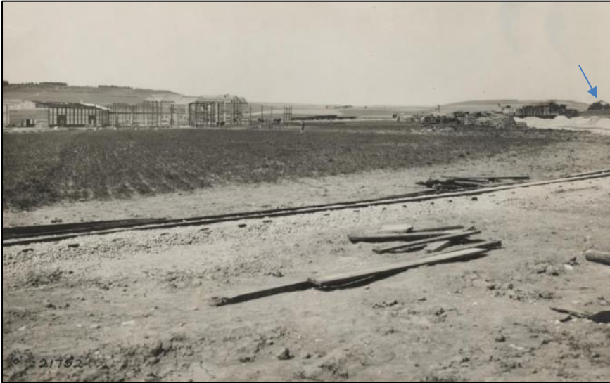
Le site est ici photographié depuis l'extrémité sud en direction du Nord. Une voie étroite est visible au premier plan. La flèche pointe la maison garde barrière du PN du chemin des Avoies.
