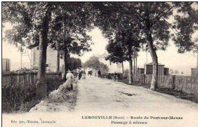
Le passage à niveau, vu en direction de Pont-sur-Meuse. A noter l'absence de voie Decauville vers le port du Canal de l'Est. Un cisaillement des voies de la C e de l'Est aurait été nécessaire.
