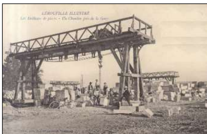
Le dépôt de pierres de la gare avec ses 3 portiques.
