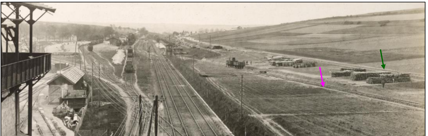
13 mai 1918. Le raccordement Ouest (flèche rose) photographié en direction de la gare de Sorcy depuis les fours à chaux. La flèche verte pointe la voie stratégique de 60 cm.
