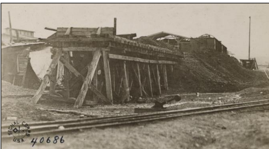
9 décembre 1918. L'estacade à charbon sur laquelle est posée une voie normale.
