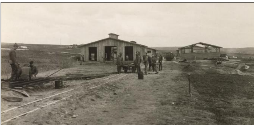
13 mai 1918. La remise aux locomotives. La voie visible part en direction du front.
