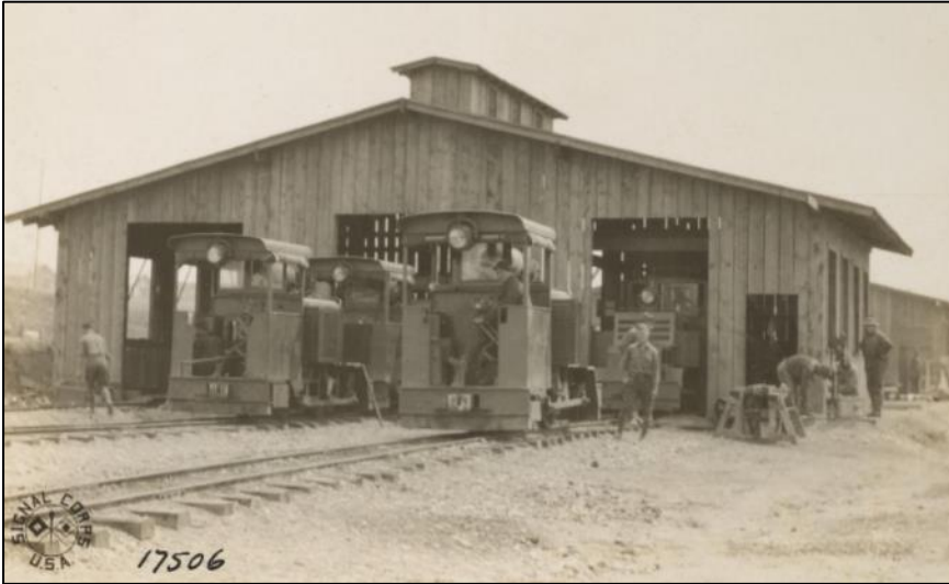
3 juillet 1918. La remise et les locotracteurs à essence.
