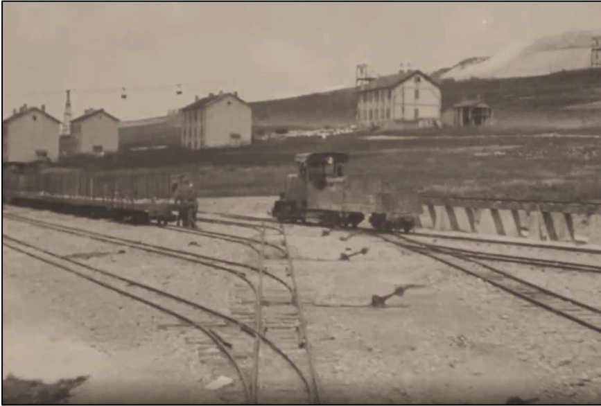
Entre le 1 er et le 3 juillet 1918. Les 4 voies du faisceau de triage utilisé pour stocker les wagons vides.
