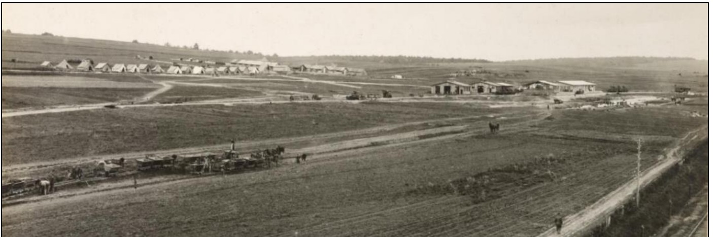
13 mai 1918. Vue générale des installations de Sorcy, avant la construction des entrepôts.
