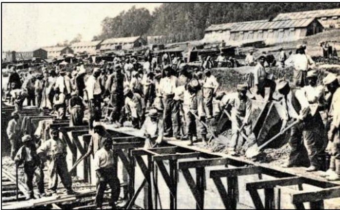
Ci-dessus en mai 1916, construction du mur de soutènement du quai haut par le 5 ème Régiment du Génie français. Ce mur est en béton et repose sur une fondation de 1 m de large. Il a une épaisseur moyenne de 30 cm sur une longueur de 450 m et est surélevé de 1 m par rapport à la voie. Ce mur va permettre de retenir un quai empierré de 400 m de long sur 12 m de large.
