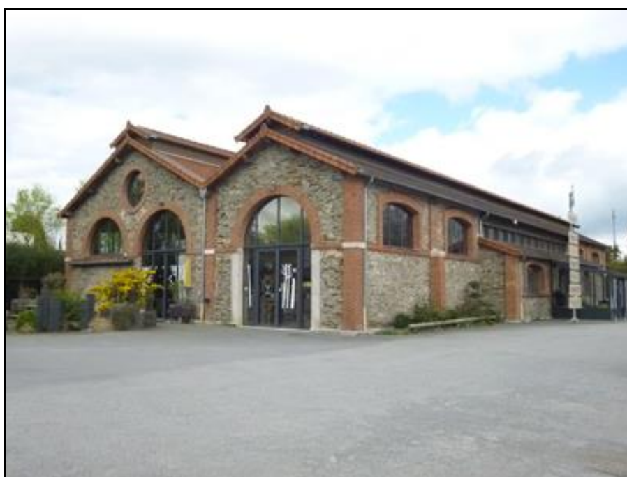
Avec ses remises à locomotives et leur évènements de toit pour l'évacuation des fumées
