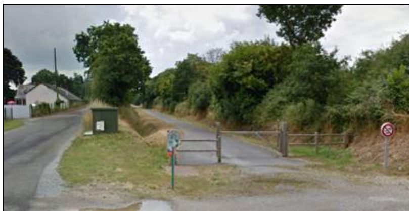
Le début de la voie verte officielle à hauteur du passage à niveau situé à l'extrémité de la gare De l'autre côté de la route, les rails sont encore présents
