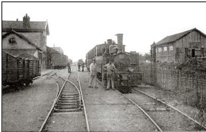
Hier, le côté voies
