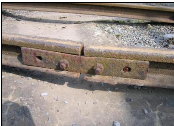
Ci-contre et ci-dessous, une éclisse vue côté écrous et un boulon de fixation du catalogue Pétolat
