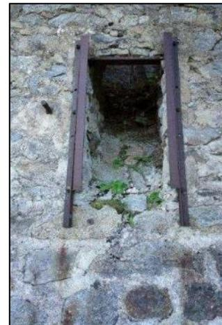
Ci-contre, l'intérieur de la trémie. Ci-dessus, l'une des six ouvertures par laquelle la stéatite se déversait dans les bennes prises en charge par le câble aérien. Trois silos sont visibles sur les vues aériennes.
