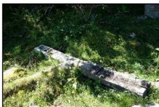
Les traverses sont issues de la coupe d'arbres abattus sur le domaine. Ils sont débités à l'aide d'une scie circulaire couplée à une locomobile à vapeur, chauffée au bois et construite pour l'occasion. Les traverses font 8 cm d'épaisseur pour 12 cm de large. Il n'a pas été trouvé de photo de la machine, mais on peut supposer qu'elle ressemblait à celle présentée ci-contre.
