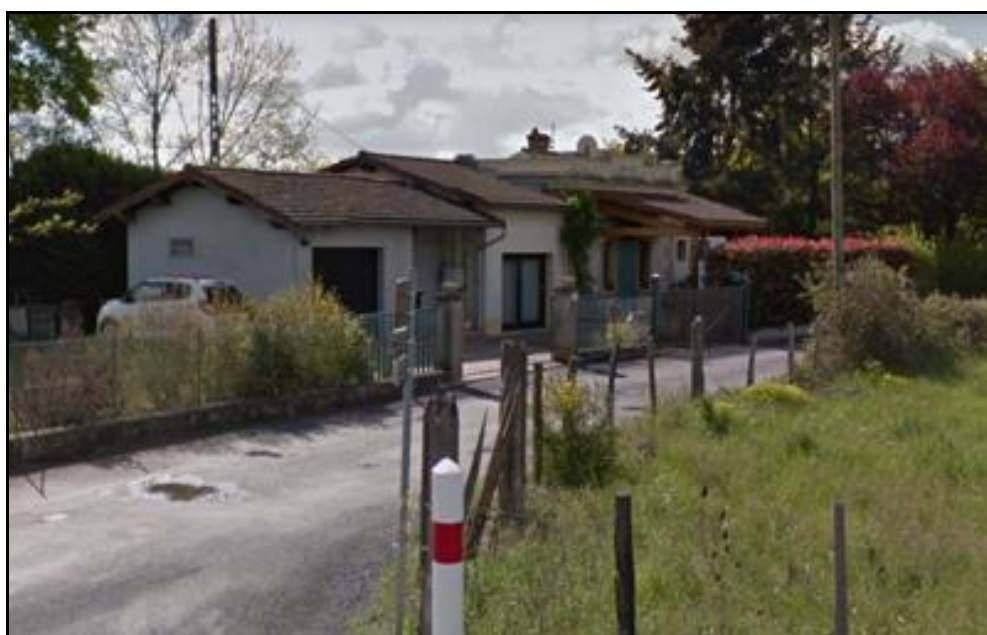
De l'autre côté de laquelle se trouve la gare de Billy Charpenay passablement modifiée mais dont on devine encore le couronnement de toit d'origine et caractéristique
