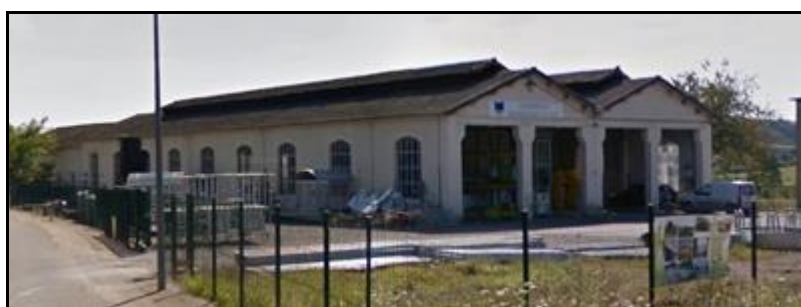
Et plus loin vers le sud, les remises toujours en usage
