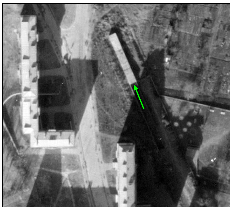
Ci-contre, vue aérienne de l'entrée du tunnel
