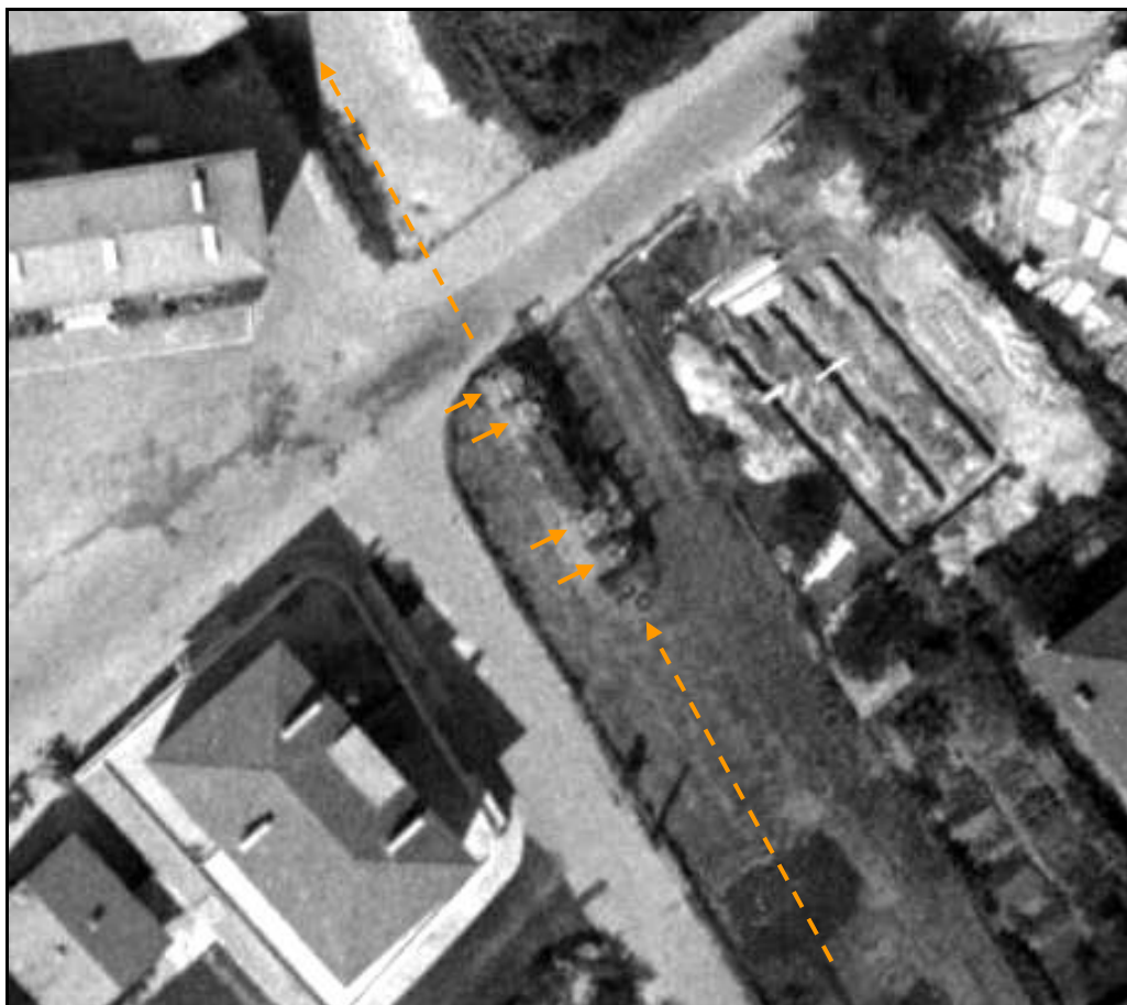
Ci-dessus et ci-dessous, à hauteur de la rue Ernest Grangeat, la station relais à la place de l'ancienne gare de déchargement Les contrepoids ronds pour tendre les câbles sont bien visibles (flèches)
