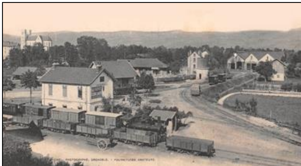
La gare de saint Laurent du Pont Avec, derrière elle, la halle marchandises en partie cachée Puis le château d'eau Et les ateliers dans le fond
