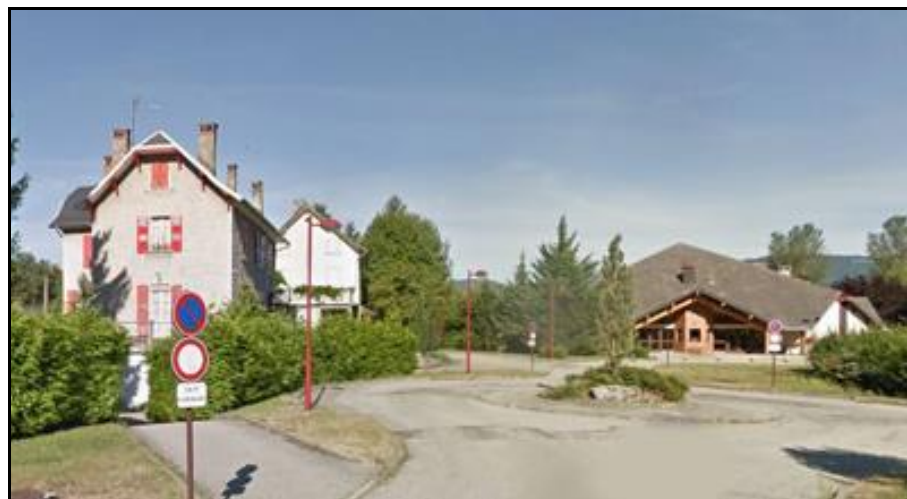
Sur cette photo actuelle, les deux maisons en partie cachées par le château d'eau de la photo ancienne Et dans le fond, le bâtiment moderne qui remplace aujourd'hui les ateliers disparus
