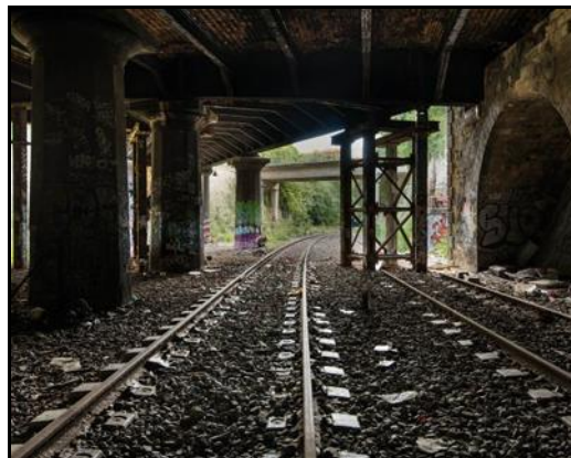
Pont supérieur en menace de rupture avec béquille de soutien posée en pleine voie
