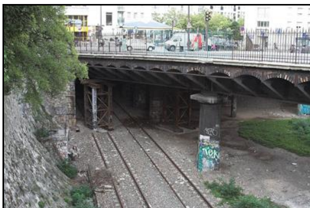
Pont supérieur en menace de rupture avec béquille de soutien posée en pleine voie
