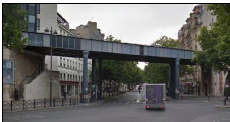
Ci-contre et ci-dessous, le pont du boulevard Diderot
