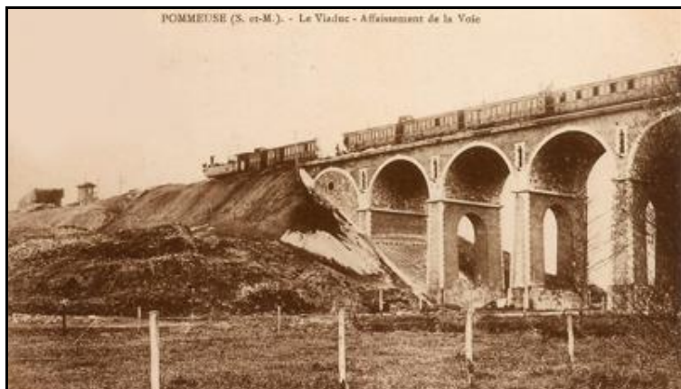
A gauche, photo d'époque montrant la zone affaissée et la première arche du viaduc renforcée A droite, le début du viaduc aujourd'hui
