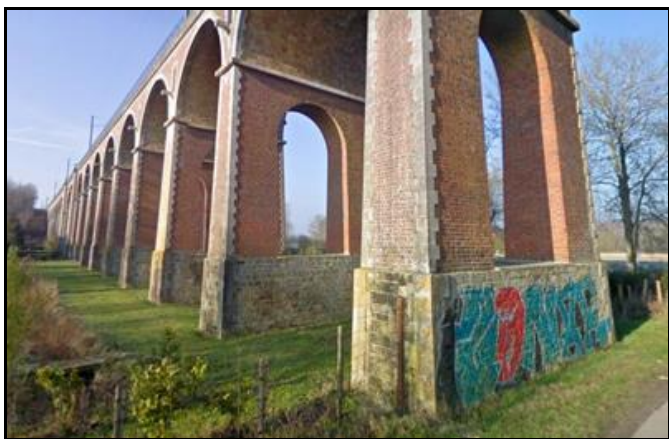
Ci-dessus et ci-dessous, détail des arches ajourées et de leurs assises en pierre de taille
