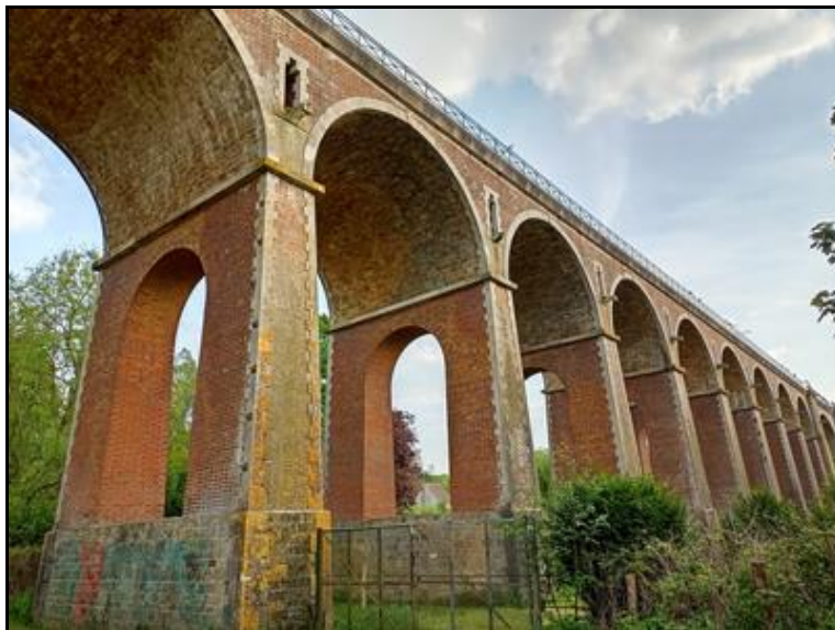
Ci-dessus et ci-dessous, détail des arches ajourées et de leurs assises en pierre de taille
