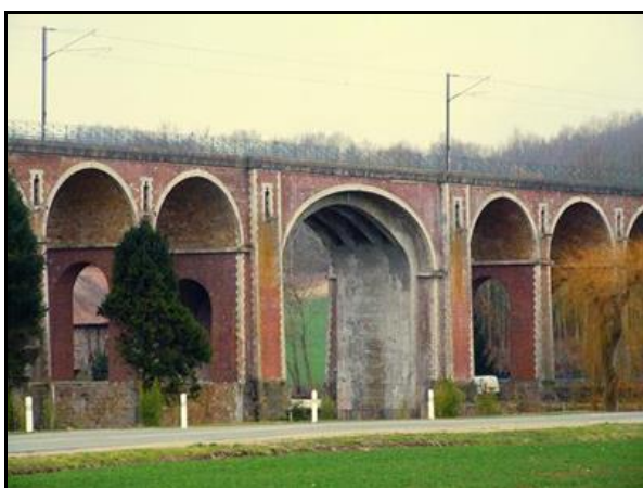
Vue par son côté gauche, la grande arche avec ses renforts bien visibles
