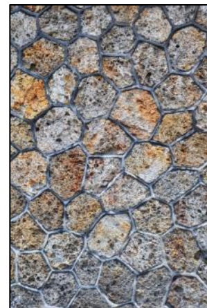
Mur en pierre meulière
