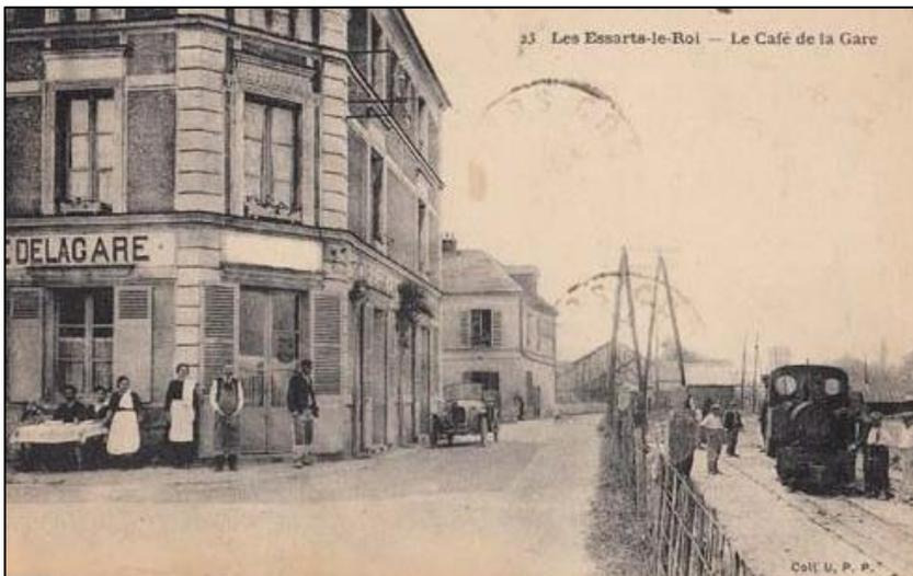
Ci-contre, les voies de 60 cm au niveau du café de la Gare dans les années 1920. Il n'y avait pas de plaque tournante à l'extrémité. Les locomotives retournaient aux carrières, cabine en avant.
