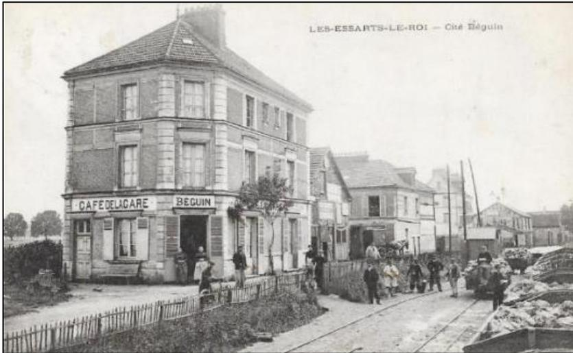
Le photographe s'étant positionné sur l'un des wagons, les deux voies étroites sont nettement visibles. L'une était parallèle à la voie normale pour permettre le chargement des wagons ; l'autre permettait la remise en tête des locomotives. Les voies étaient surélevées d'un mètre par rapport à la voie normale.
