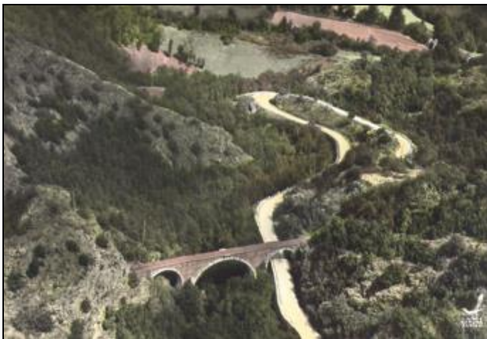
Vue générale du méandre de Landissou avec le pont de Gourp Fumant encadré par le tunnel de Costefer à gauche, et celui de Gourp Fumant à droite
