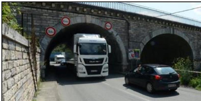
C'est pourquoi, courant 2015, le pont a été allongé et une nouvelle arche de 4 m de large et de 4,60 m de haut a été construite pour créer des sens uniques de circulation. Bien que différente des autres arches, il est à noter qu'elle a été réalisée en pierre et qu'elle respecte donc l'architecture initiale de l'ouvrage.
