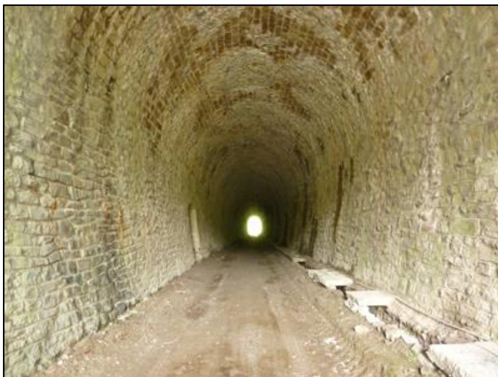
Dont on voit ici l'entrée, la sortie et la belle galerie avec son drain latéral
