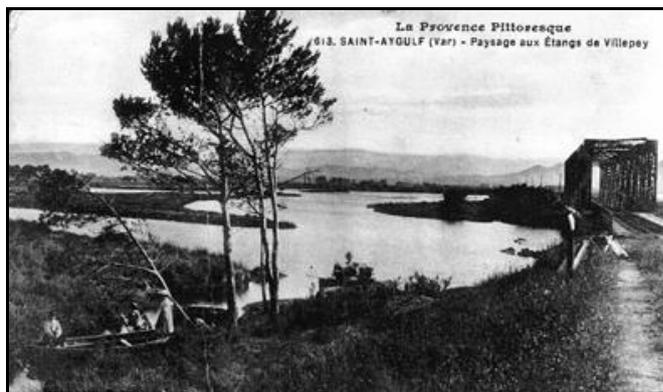
A la sortie de Saint Aygulf, la voie ferrée franchissait le grand chenal de l'étang de Villepey par un pont cage métallique de 55 m de long construit par la société Eiffel. Il n'en restait que la culée nord toujours visible.
