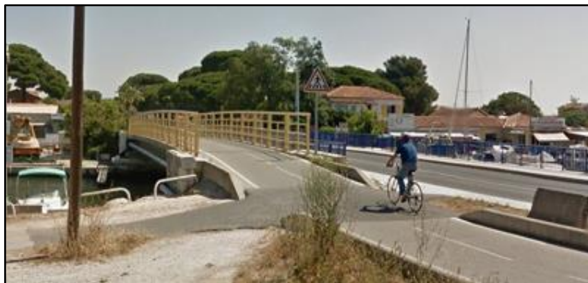
Le pont du Roubaud
