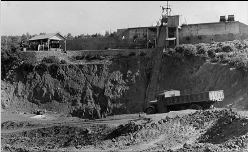
Le bâtiment des treuils et les trémies vues depuis la carrière. A noter les deux wagonnets au sommet de la trémie. Aucun réseau n'étant visible dans la carrière, on suppose que les wagonnets étaient chargés au pied du plan incliné avant d'être remontés sur une courte voie qui existait au sommet des trémies.
