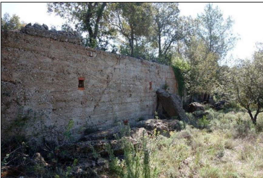
Les ruines en béton des trémies.
