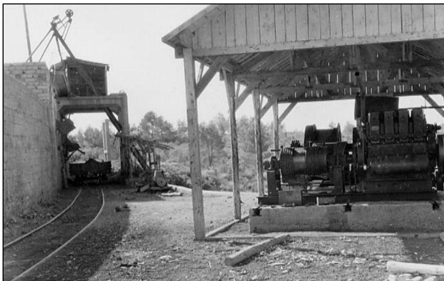
Ci-contre, vue du transbordement du côté Ouest avec à droite, le mécanisme de treuils, hier et aujourd'hui.
