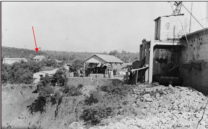
Lest trémies et le bâtiment des treuils vus en direction du Nord. On aperçoit la gare de Rognette-Cotignac, pointée par la flèche rouge.
