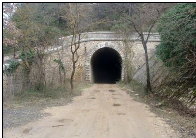
Ci-contre, juste après la gare, le tunnel courbe de Saint Pothin, 76 m de long, dont voit ici l'entrée, et la galerie et la sortie ci-après
