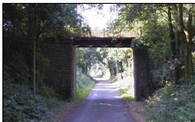
Le pont de l'Essaudière
