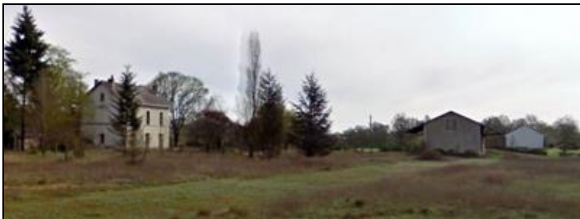
Vue à contresens de la ligne, la gare et sa halle à marchandises
