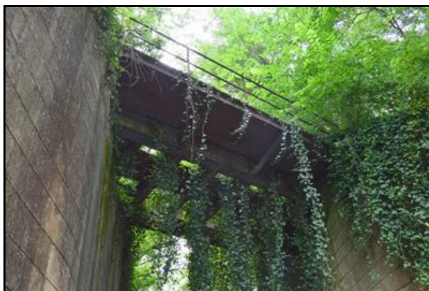
Dont le tablier est réduit à l'état de squelette
