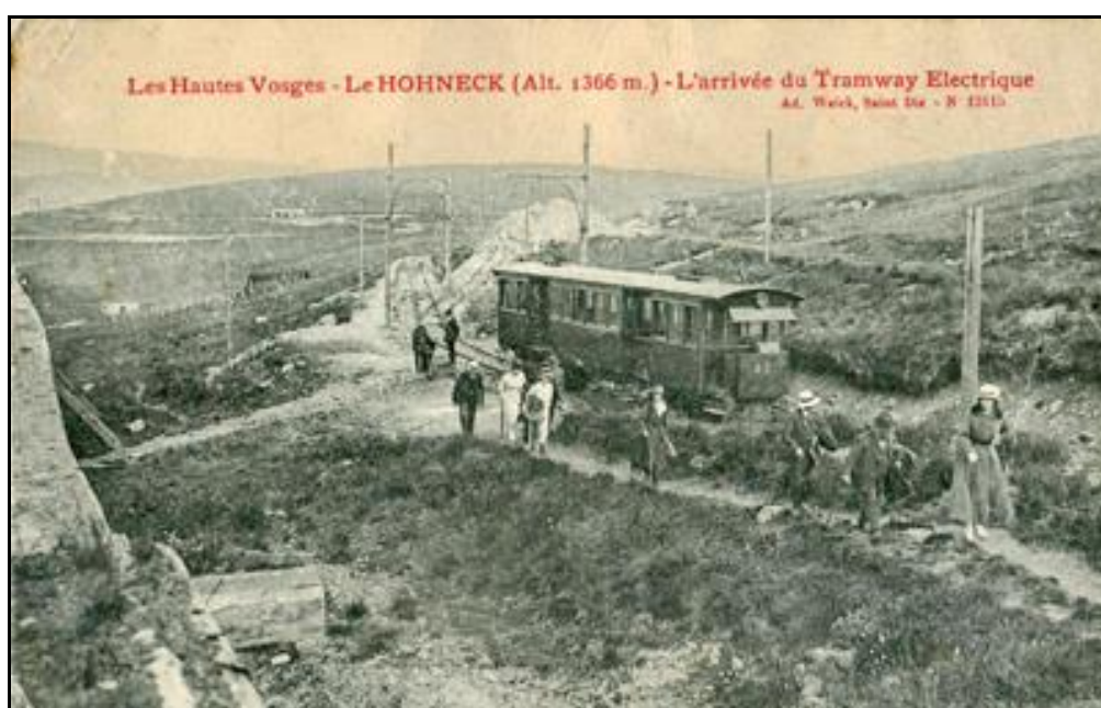
La fin de la ligne avec la voie de garage à l'arrière-plan
