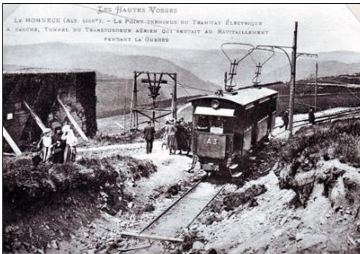
L'arrivée du tramway peu après la guerre, alors que le transbordeur militaire est encore en place A gauche, le faux tunnel de protection qui précède le vrai tunnel sous la crête
