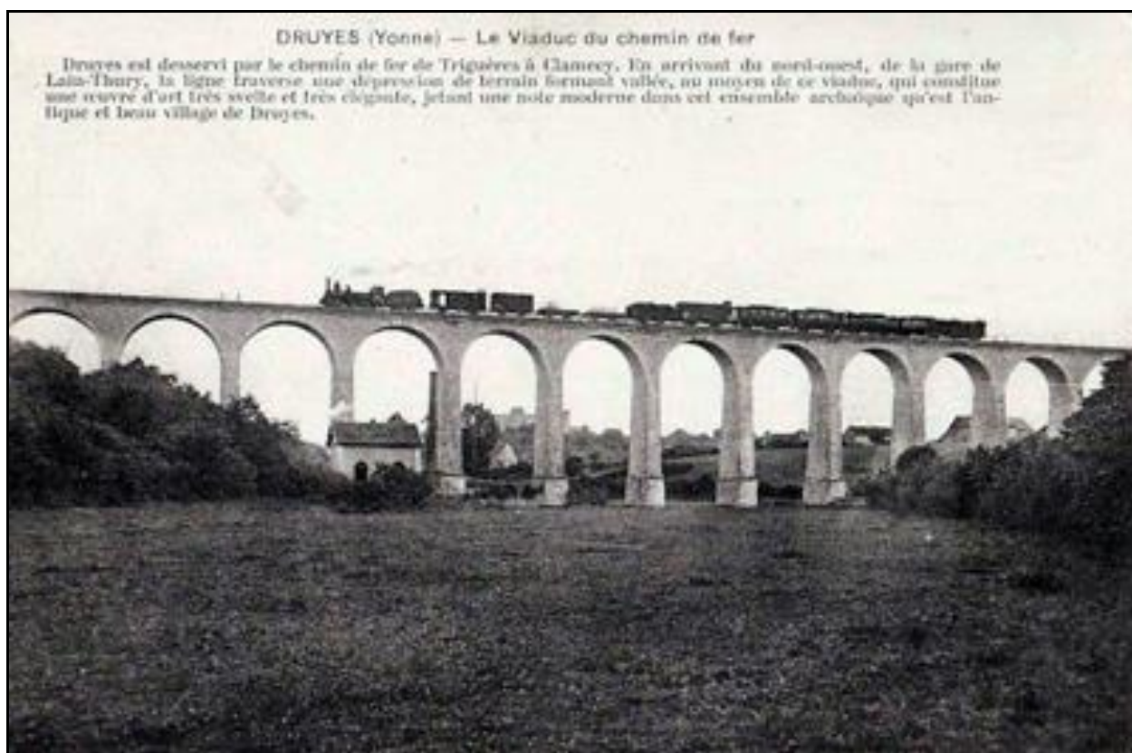
A commencer par son beau viaduc (ellipse bleue sur l'extrait de carte ci-avant) Construit entre 1880 et 1883, cet ouvrage de 182 m de long et 30 m de haut, compte 12 arches de 12 mètres d'ouverture
