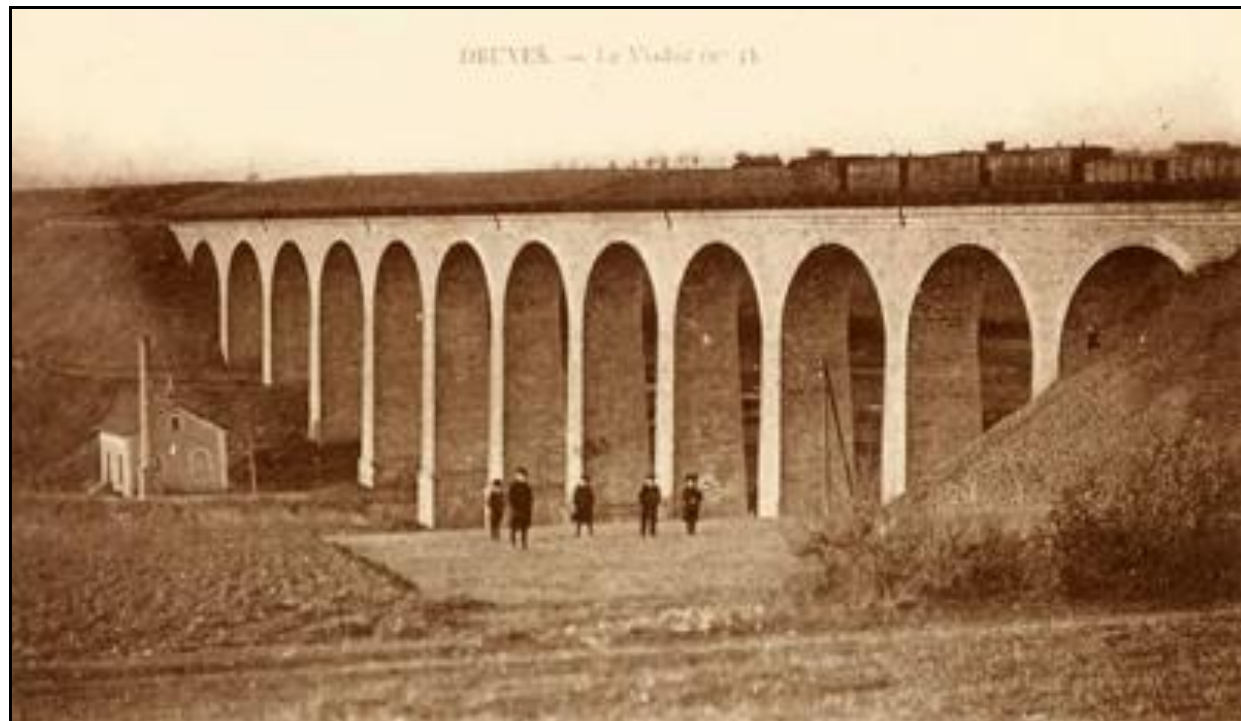
Le viaduc avec, à son pied, la petite station de pompage pour alimenter le château d'eau de la gare
