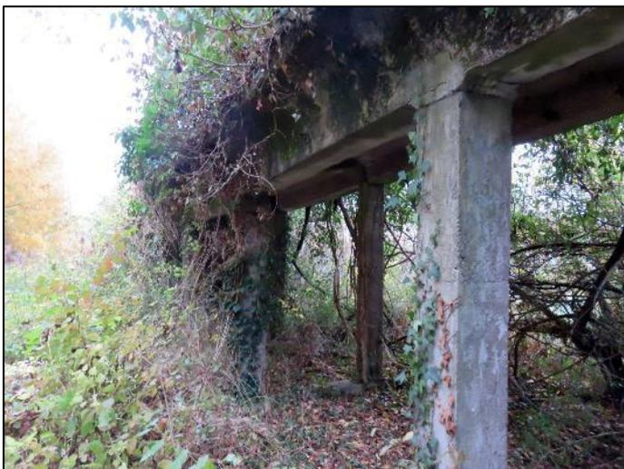
L'estacade mesure 40 mètres de long et 2,5 mètres de haut. Elle est soutenue par 31 piliers. Les wagons-tombereaux y accédaient après avoir gravi sur 105 mètres, une rampe de 2,5%.
