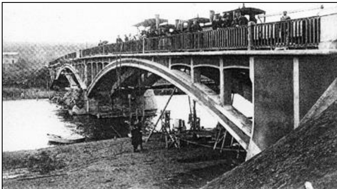
Ci-dessus et ci-dessous, finition du premier pont avec sa sculpture de chevaux sur la pile centrale
