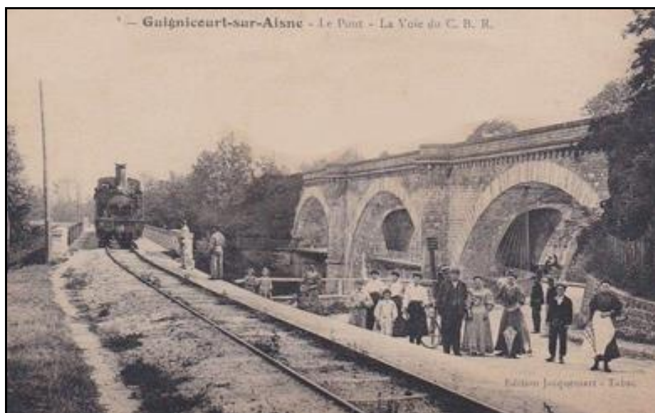
Le pont vu en regardant vers le sud A sa droite, le pont ferroviaire de la ligne Reims > Laon Noter que ce pont livrait passage inférieure à une route qui traversait ses piles
