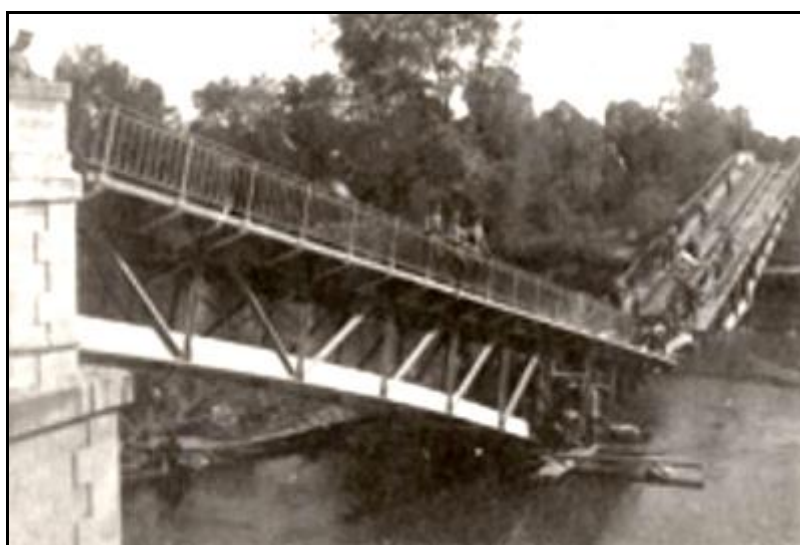
Le pont du CBR dynamité
